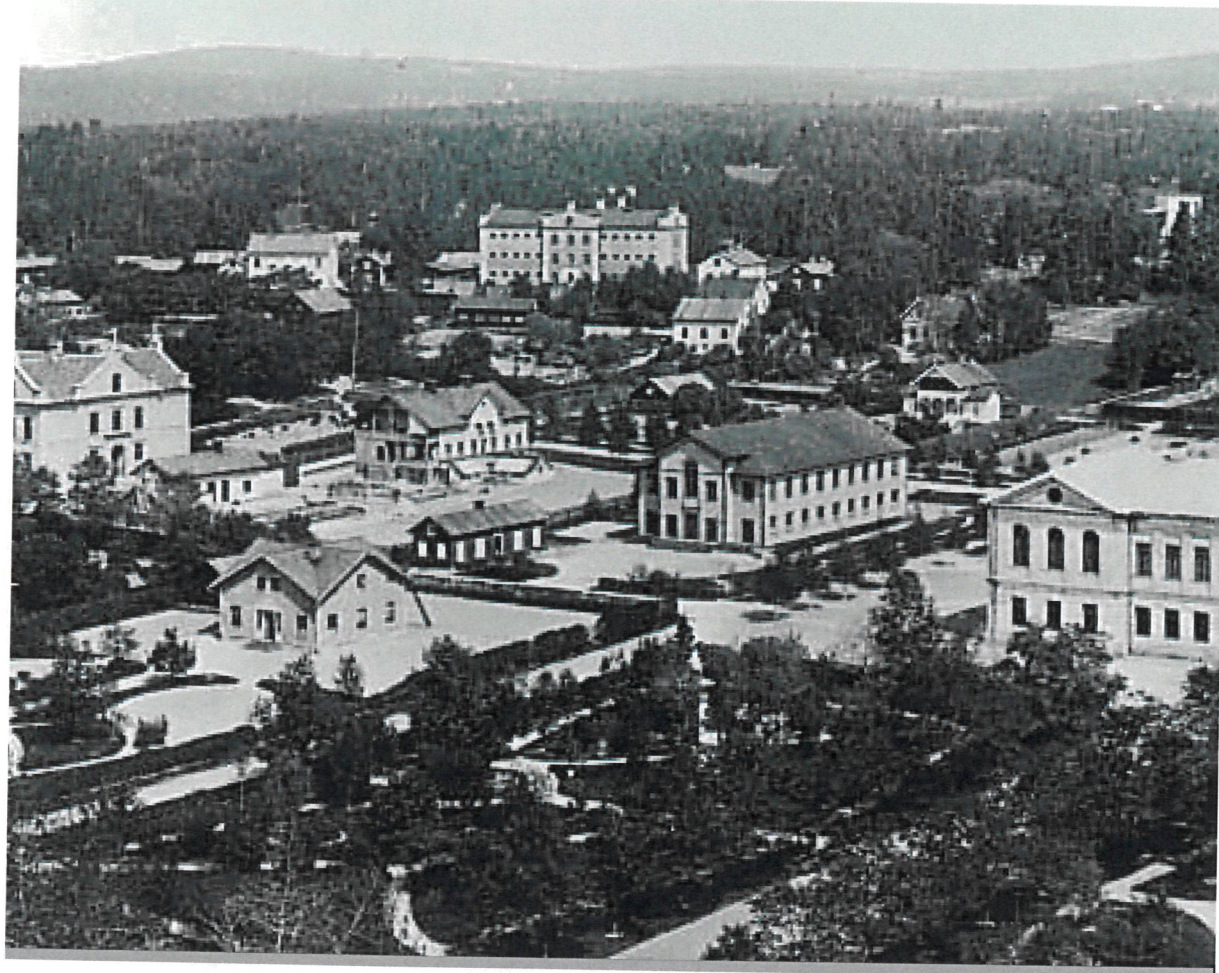
Slöjdskolan i parken till vänster byggdes 1861 i ett kvarter som tidigare varit odlingsmark. Kvarteret bebyggdes senare med Elementarläroverket till höger, Missionskyrkan i mitten och Östra Folkskolan längst till vänster. I skogskanten syns länsfängelset från 1848. Foto: Stora Enso arkiv.
